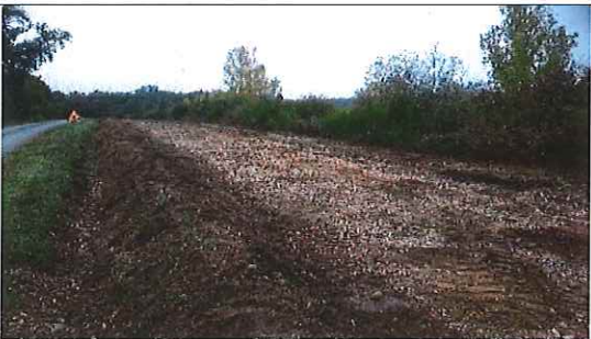
Terrain compensatoire au lieu-dit « Le Pendut » après décapage du sol (BIOTOPE)
