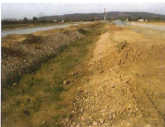
Fossé de collecte des eaux
