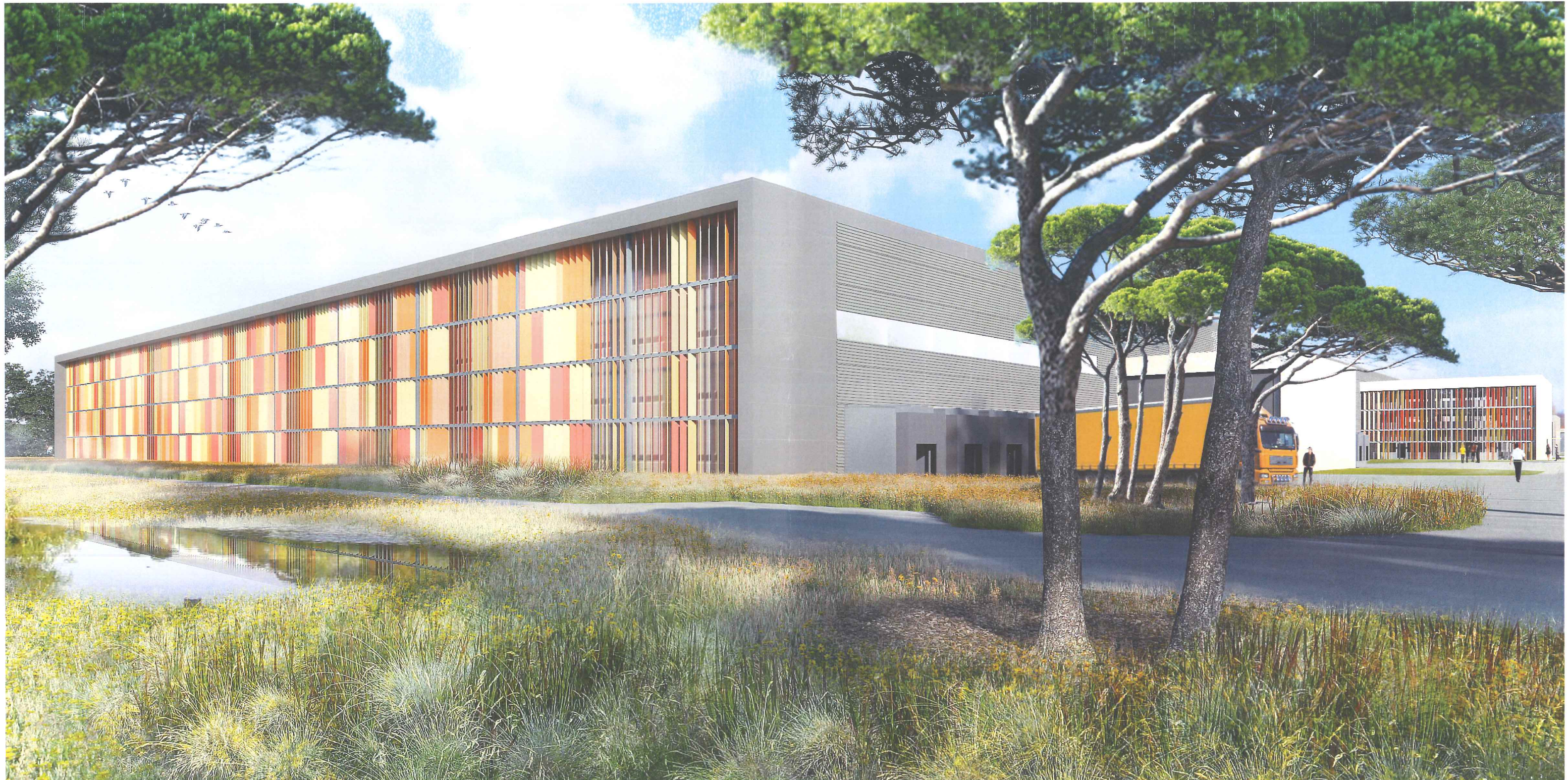
Detail du pignon Est avec brises-vues
