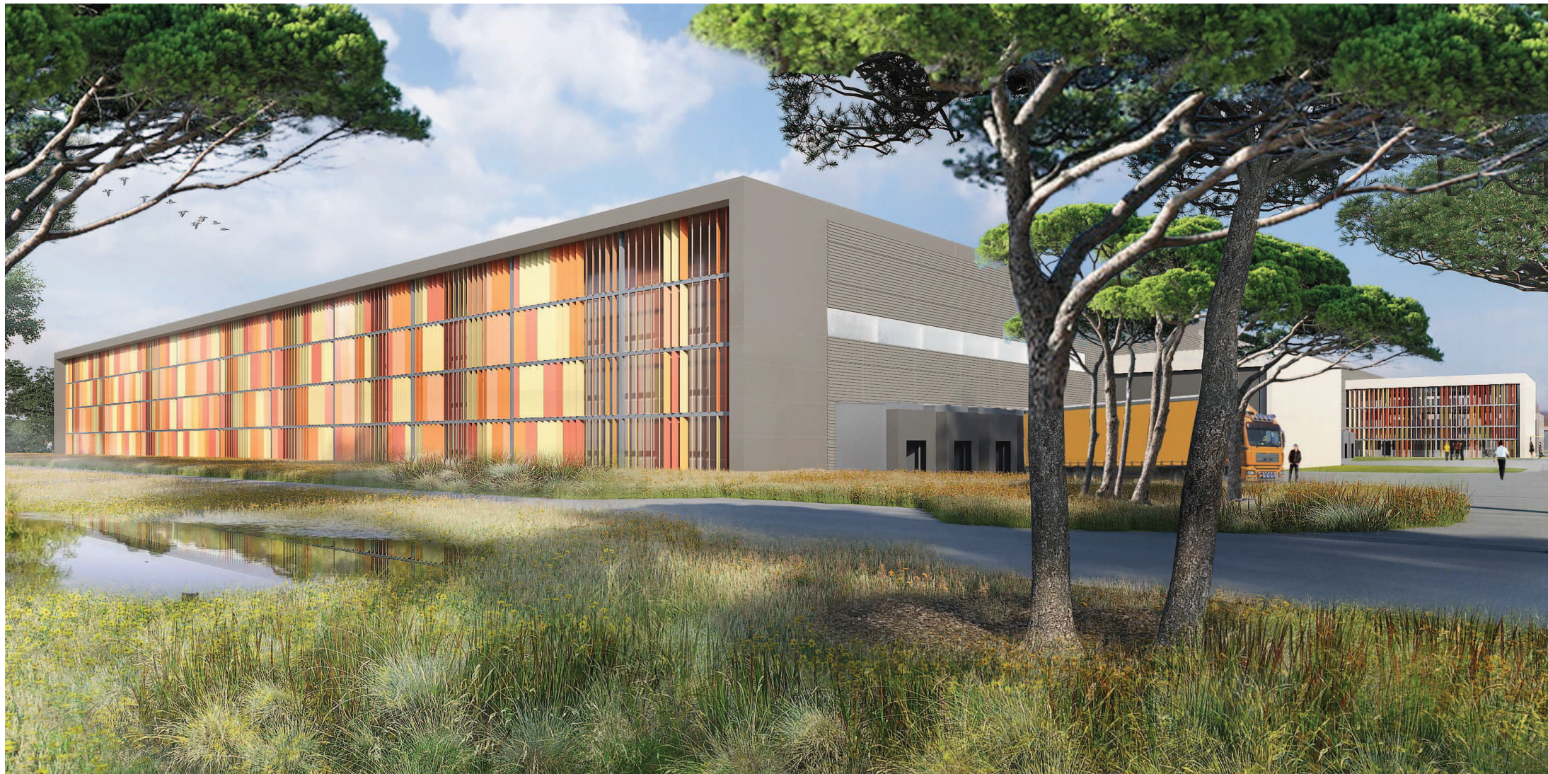
Detail du pignon Est avec brises-vues
