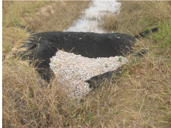
Principal bassin de décantation et son système de filtration
