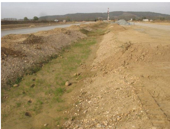
Fossé de collecte des eaux
