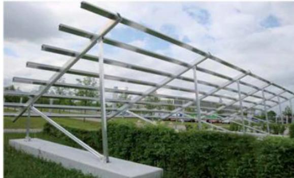
Figure 14 : Exemple de châssis métallique reposant sur des longrines béton
