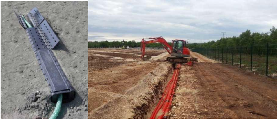
Figure 10 : Exemple de caniveau et de mini-pelle
