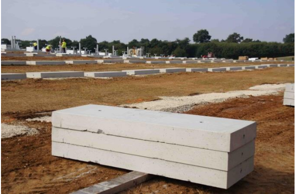
Photo 9 : Illustration de longrines béton préfabriquées
