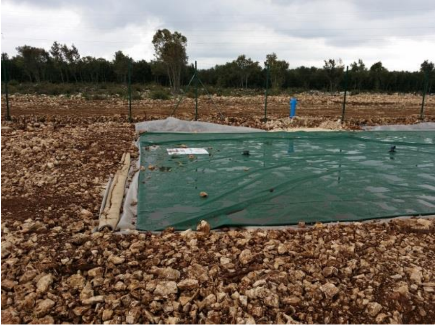
Photo 14 : Illustration d'une citerne souple avant remplissage
