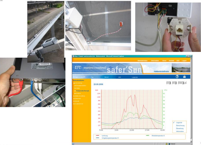
Figure 13: Mise en place du système de monitoring
